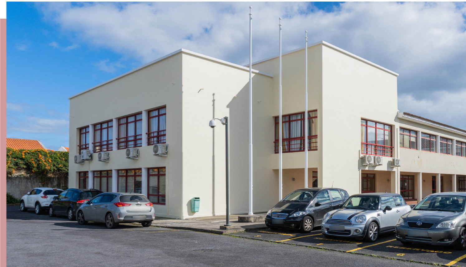
Fachada Oeste da Fundação Gaspar Frutuoso
