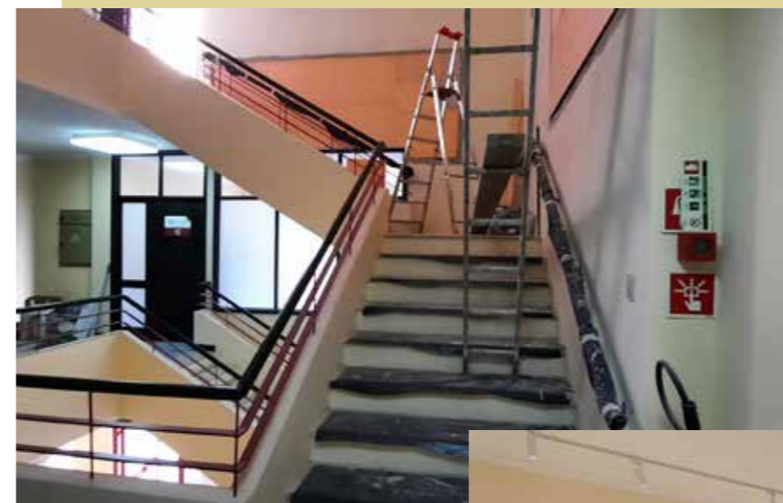
Hall de entrada antes das obras
