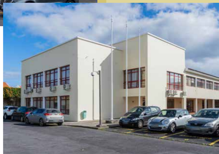
Fachada depois das obras
