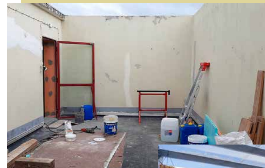
Pátio exterior antes das obras
